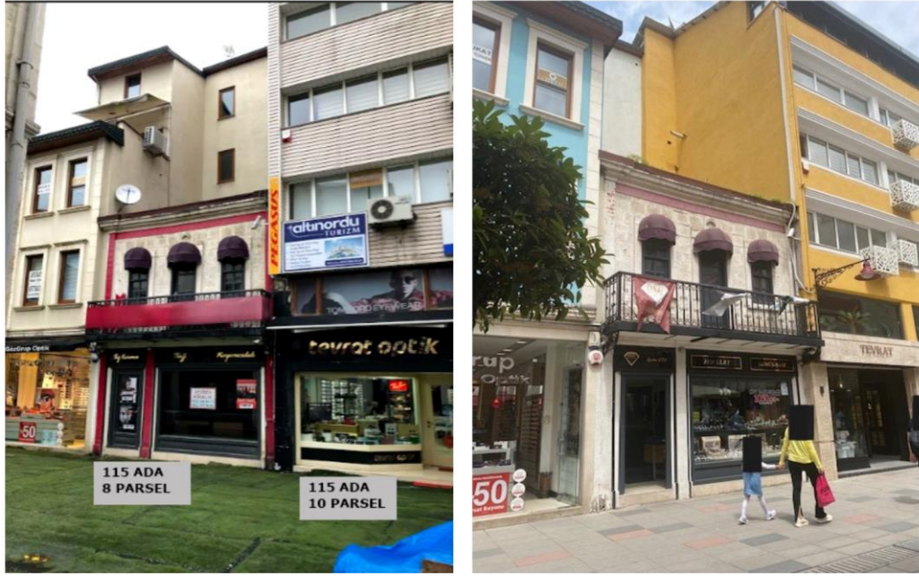
Şekil 2.13: 115 ada 8 parsel, 115 ada 10 parsel-önce/sonra
