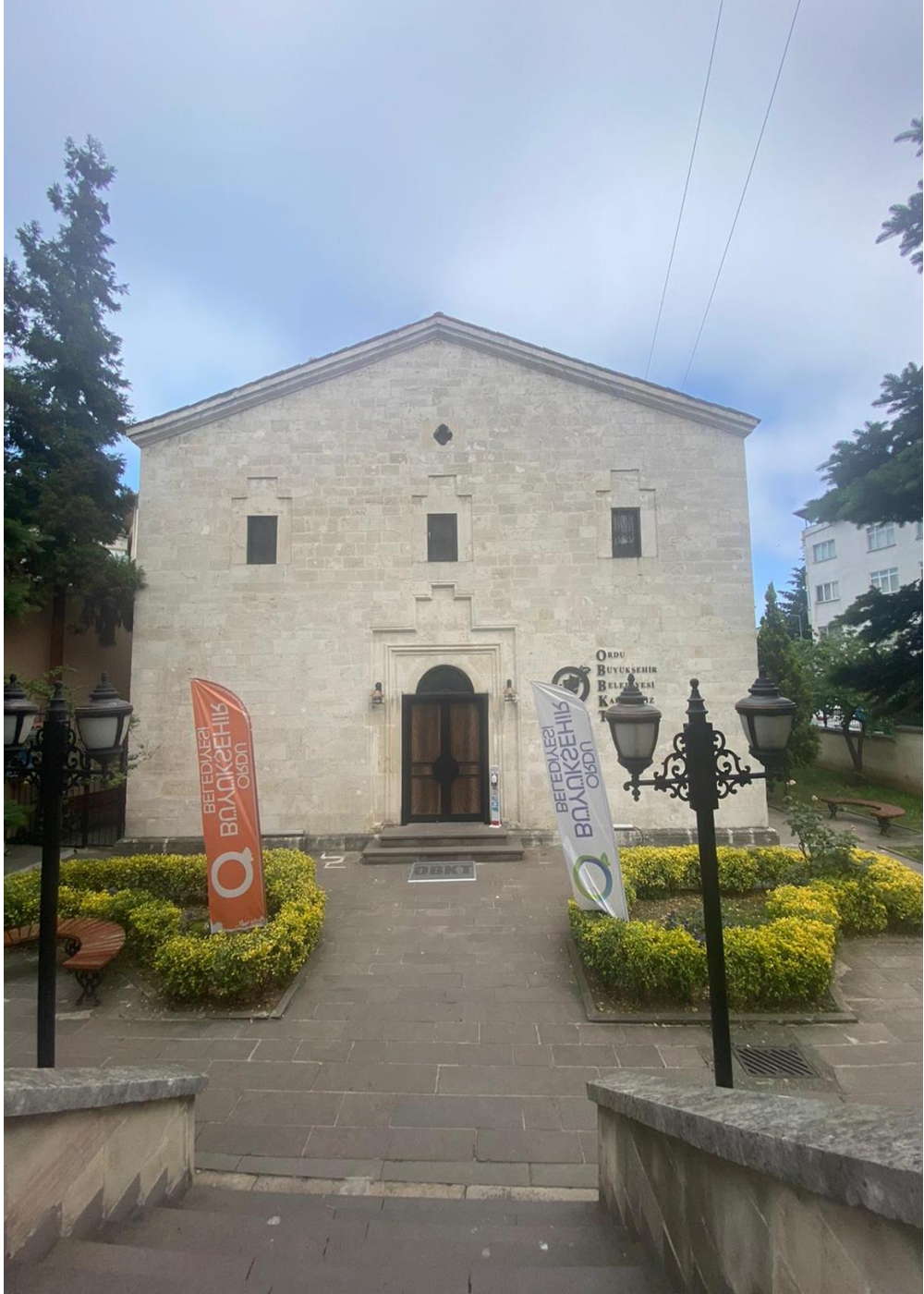
Şekil 2.21: Tiyatro Binasının ana girişi
