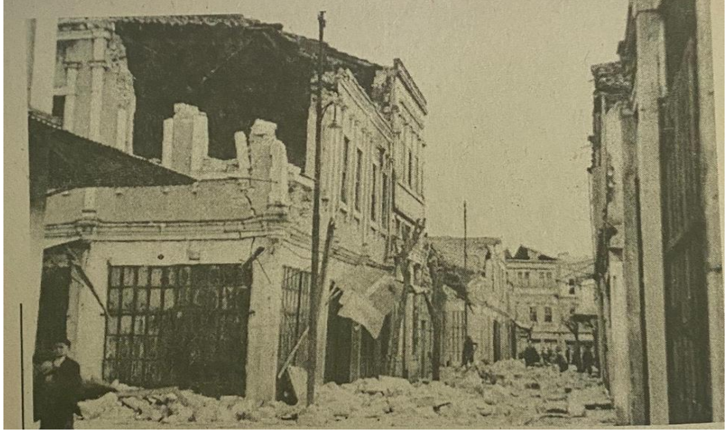
Şekil 2.4: 1939 yılındaki depremde Sırrı Paşa Caddesi
