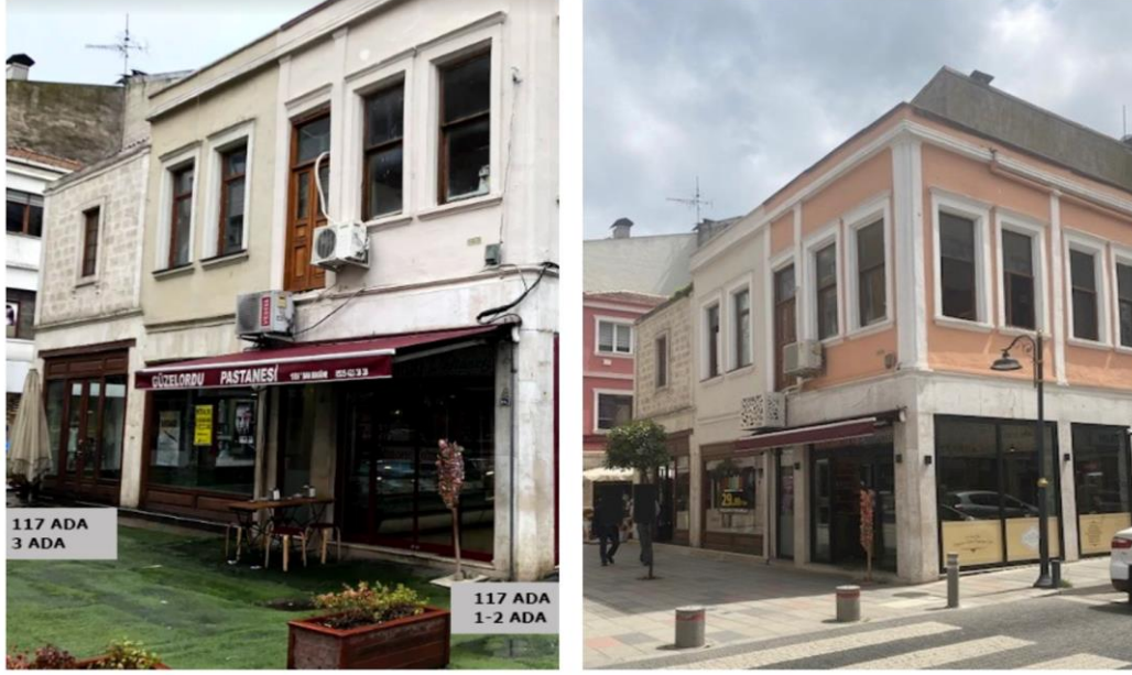
Şekil 2.15: 115 ada 8 parsel, 115 ada 10 parsel-önce/sonra
